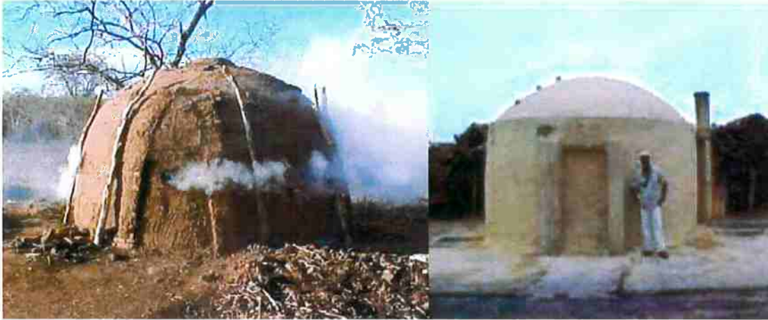
Figura 5 - Forno "rabo quente" sem chaminé (esquerda) e com chaminé (direita), extraído de (10).
